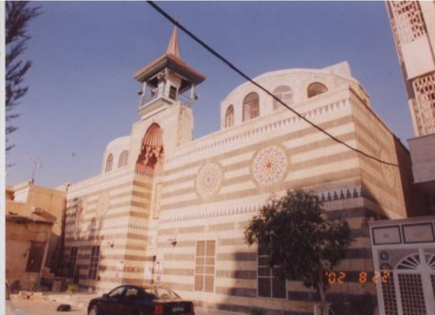
لوحة (٢) الواجهة الرئيسية وجزء من الواجهة الجنوبية لتربة الأمير تنبك الحسني تصوير الباحث
