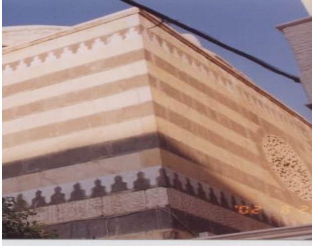
لوحة (٣) جزء من الواجهة الجنوبية لتربة الأمير تنبك الحسني تصوير الباحث
