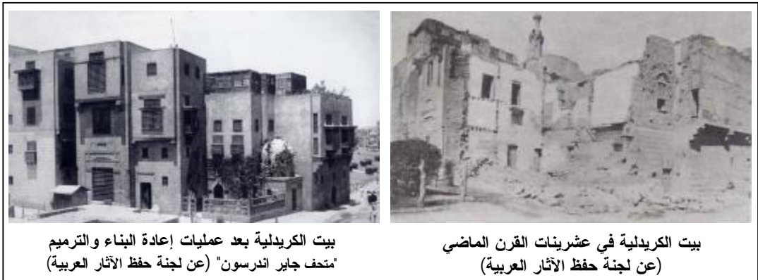
شكل (٥): عمليات إعادة البناء لبيت الكريدلية
