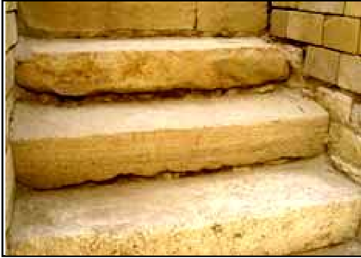
إعادة إستخدام بعض الكتل الفرعونية داخل قلعة قايتباي برشيد
