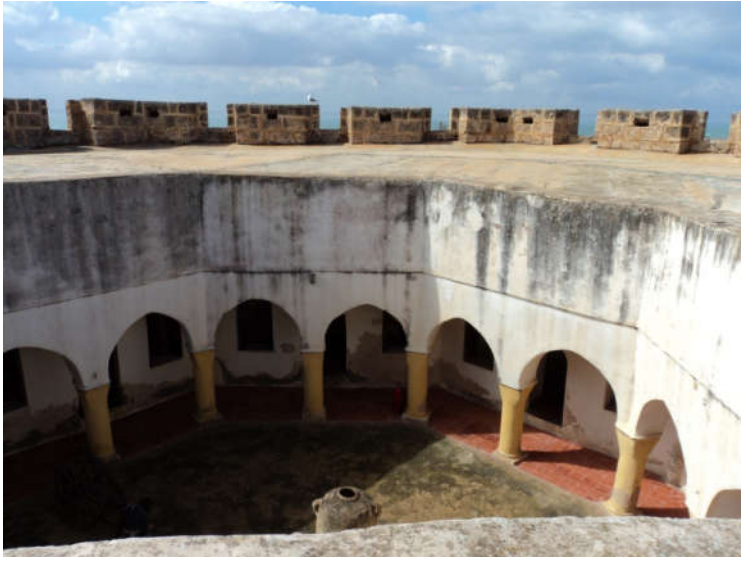
(صورة رقم ٠٥) منظر داخلي لحصن تامنتفوست يبدو الفناء و المرافق المحيطة به
