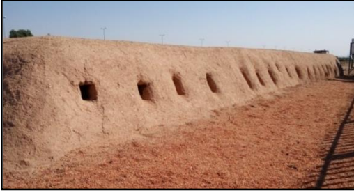
لوحة رقم ٢٧ الجناح الجنوبي لطابية الدباغة بعد الصيانة (اللياسة). تصوير الباحثة.
