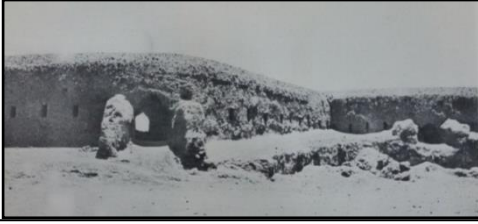
لوحة رقم ١٣ صورة أرشيفية لطابية الملازمين الجنوبية، ويظهر بها السواتر التي تتقدم فتحات المراقبة. عن عصمت زلفو، كرري.
