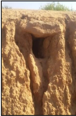
لوحة رقم ١١ استخدام الأحجار كأعتاب لفتحات المزاعل في طابية توتي الشمالية. تصوير الباحثة.
