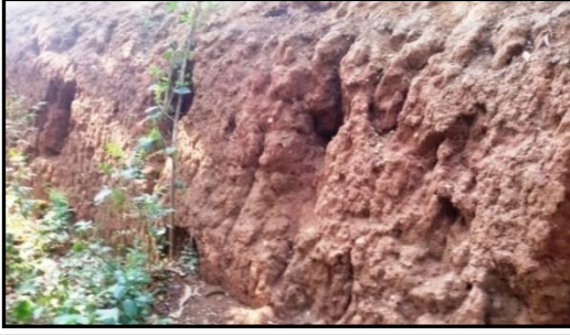
لوحة رقم ٥١ استخدام الجالوص في تشييد جدران طابية شمبات. تصوير الباحثة.
