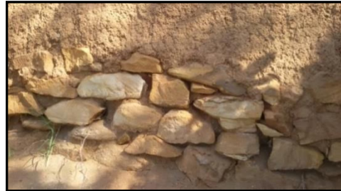
لوحة رقم ١٠ الجزء الجنوبي الغربي لطابية توتي الشمالية من الخارج، ويظهر استخدام الأحجار في الأساسات السطحية. تصوير الباحثة.
