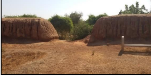
لوحة رقم ٢ المدخل الرئيسي في طابية توتي الشمالية من الداخل، تصوير الباحثة.
