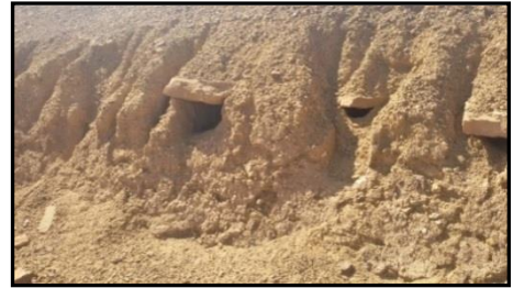
لوحة رقم ٤٢ استخدام الحجر كعتب لفتحات المزاعل في المسافة بين فتحة المراقبة الرابعة والباب الرئيسي. تصوير الباحثة.
