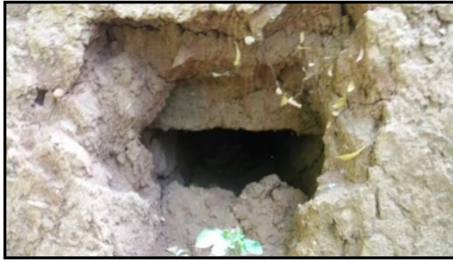
لوحة رقم ٤٩ أحد فتحات المزاغل في طابية شمبات، واستخدام الحجر كعتب. تصوير الباحثة.
