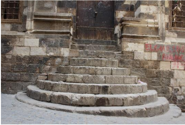
(لوحة ٢) سلم دائري يتقدم مدخل مدرسة الأمير متقال بالواجهة الشمالية الشرقية.
