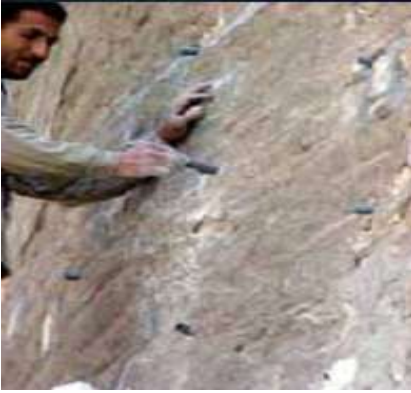
صورة (٢٣) توضح تحضير الجدران للحقن. After: Elbarbary, W, 2005.
