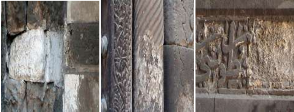
صورة (١، ٢، ٣) توضح تأثير الرطوبة على تلف مواد البناء في مسجد الطنبغا المراداني وسبيل وكتاب عبد الرحمن كتخدا وسبيل فاطمة خاتون عن: محسن محمد صالح (دكتور): ٢٠٠٥م.
