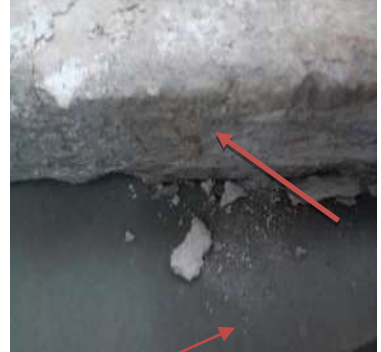
صورة (٨) توضح تفتت وسقوط أجزاء من اللوحات
